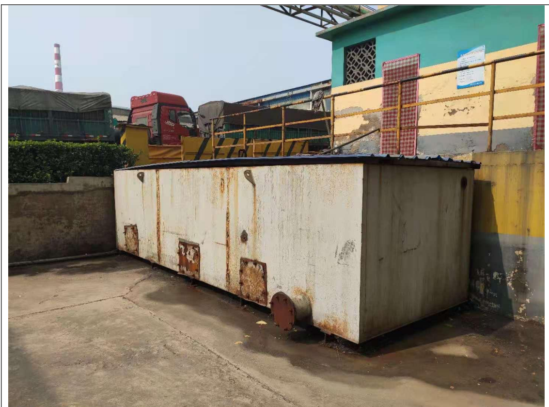
料场洗车废水储存池
